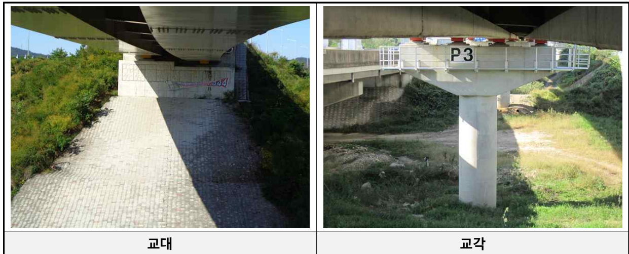
[교대 및 교각 전경]
