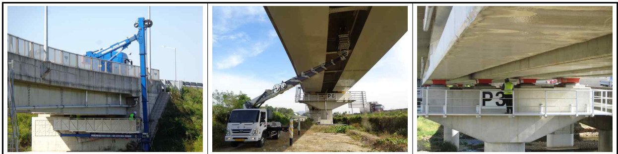
[고소작업차, 굴절점검차를 이용한 근접조사 실시]
