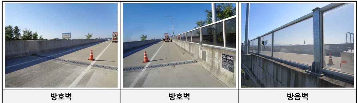
[방호벽 및 방음벽 전경]
